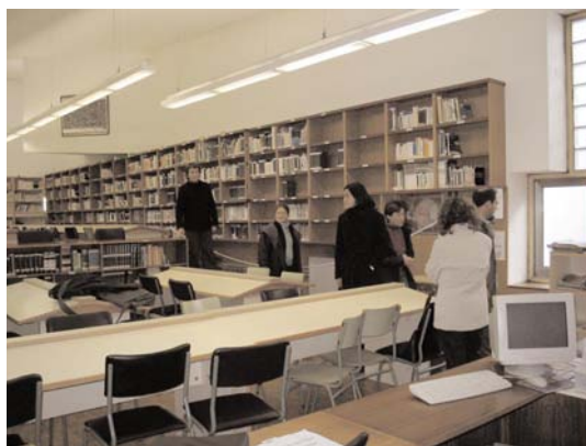
3. La biblioteca antes de la reforma. Visión de la parte principal desde el puesto de bibliotecario/a.
