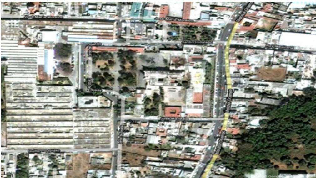
Fig. 2. Ortofotografía E14A18C de Tepeji del Río donde se señala con una flecha la localización del Convento de San Francisco de Asís.
