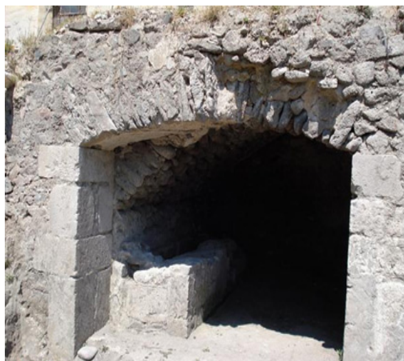
Fig. 8. Detalle del acceso, donde se aprecia cómo se encuentra adosada la fachada a la bóveda interior. Este detalle lo que indica es que la función de la bóveda cambió, ya que se dividió por medio de dos accesos.
