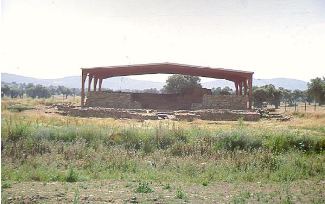
Imagen 4: Cancho Roano 1998, con la cubierta instalada en 1987 (Foto J. Jiménez).
